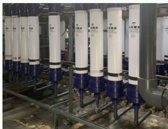
纯水超滤装置更新
